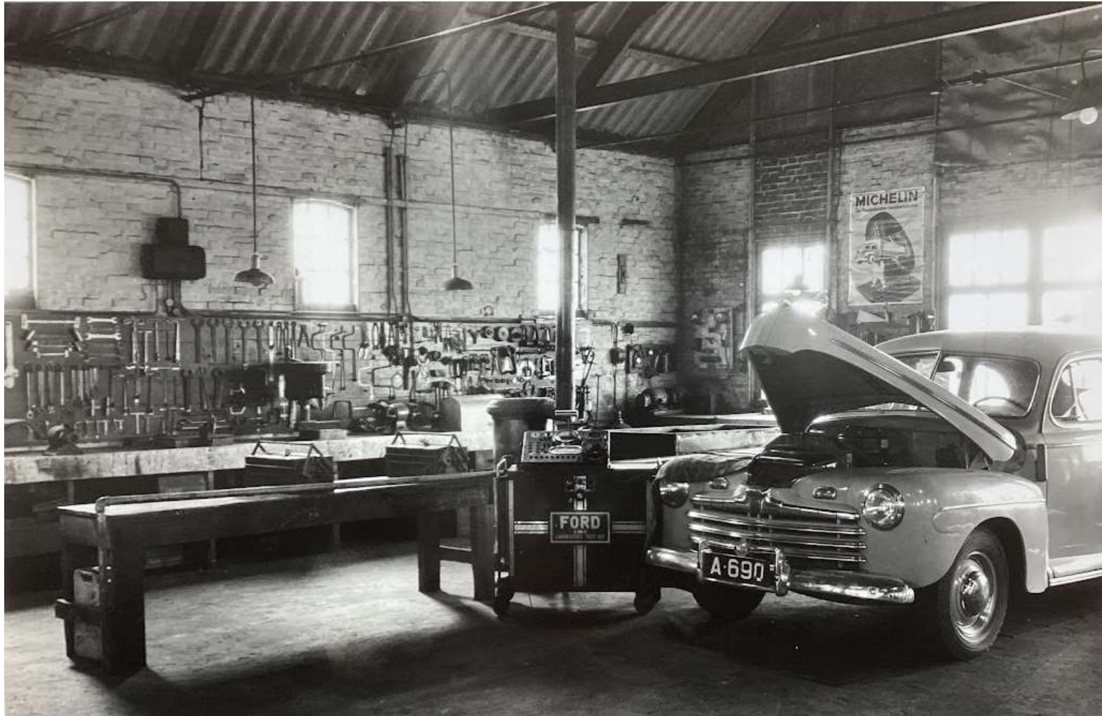
Interieur van de Ford werkplaats 1953. Ford V8 (1947) met origineel testapparaat. Nicolaas was vanaf 1924 officieel dealer van Ford automobielen, tractoren en vrachtwagens. De afdeling landbouwtractoren werd gerund door 2 broers van hem in Ulrum, Roelof en Jan Bakker. Let ook op het gereedschap aan de wand. Wanneer je een stuk wegnam, bleef de tekening zichtbaar zodat je zag waar je het terug moest hangen na gebruik.
