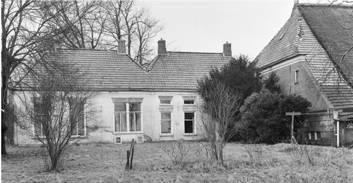
Foto uit 1969 door A.J. van der Wal uit de Beeldbank cultureel erfgoed. De boerderij was een voorwerk van het klooster Wijtwerd bij Usquert. De hele oostwand is dan nog bepleisterd en op het dak van de schuur ligt nog geen asbest. Op de volgende foto zie je wat 'aanpassingen' teweeg kunnen brengen.
