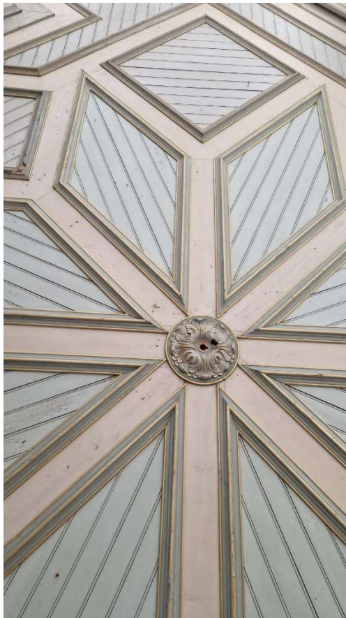
Plafond in de voorkamer
