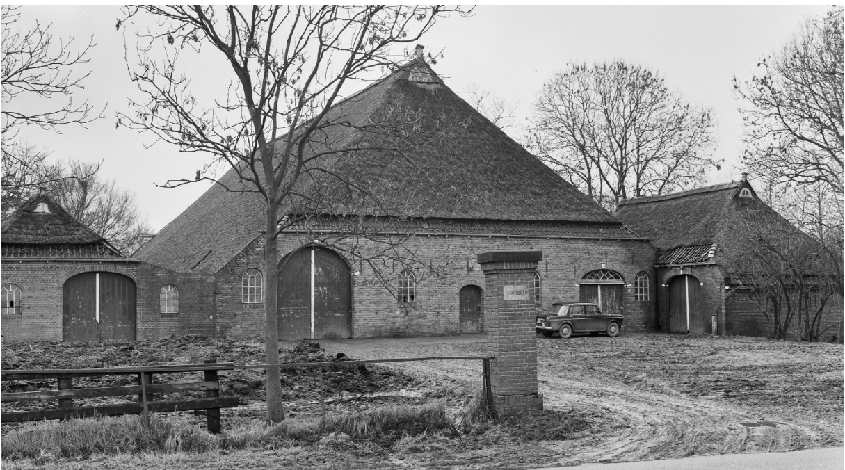
Een foto zoals iedereen die wel langs Maarhuizen fietst of loopt die zal kennen. Deze foto is gemaakt door A.J. van der Wal in 1969. De gemetselde toegangspaal is ontworpen en gemaakt door provinciale waterstaat tijdens een wijkverbetering in de jaren rond 1925. Er is een tekening van bewaard gebleven, die hier volgt.
