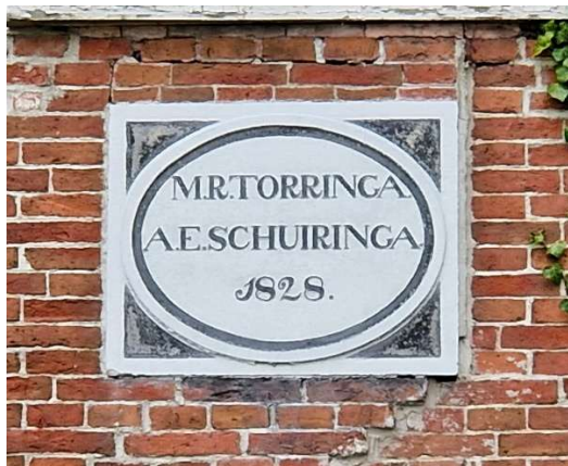
Gewelsteen in de voorgevel (no. 6 en7).
